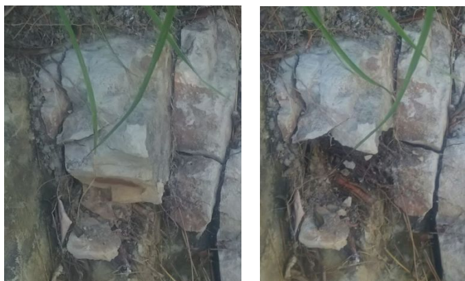
(左)を少し手で触っただけで(右)の様に崩れる。
