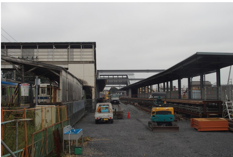
愛宕駅仮線工事（写真右半分）。新たなホームや跨線橋ができつつある。
