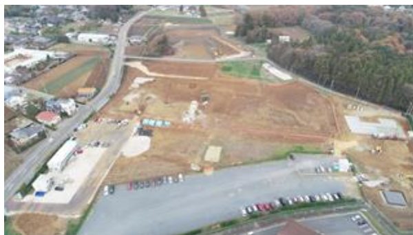
本年11月末のひたち野うしく中学校の工事状況
